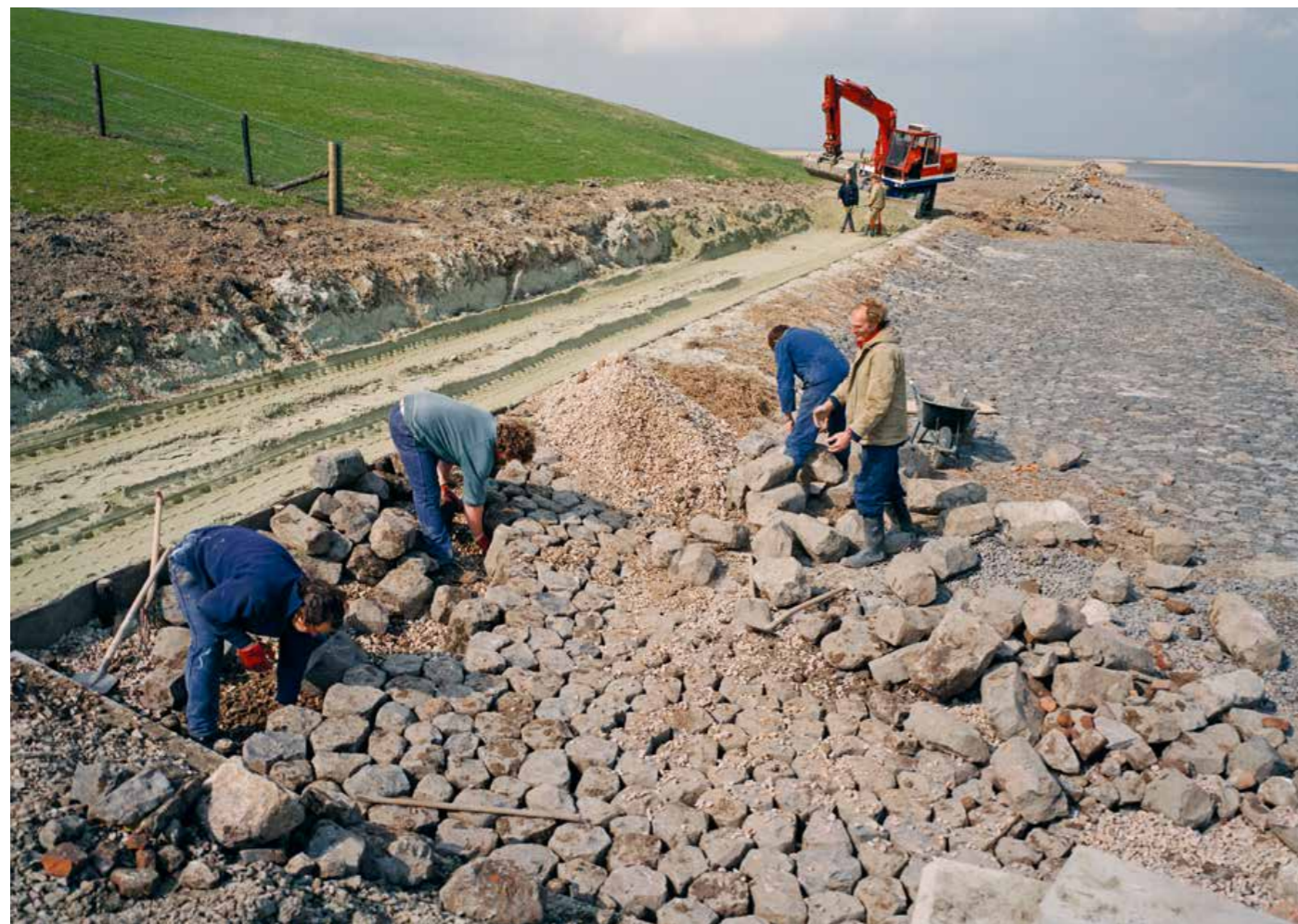
Herzetten van een steenbekleding, 1991.
