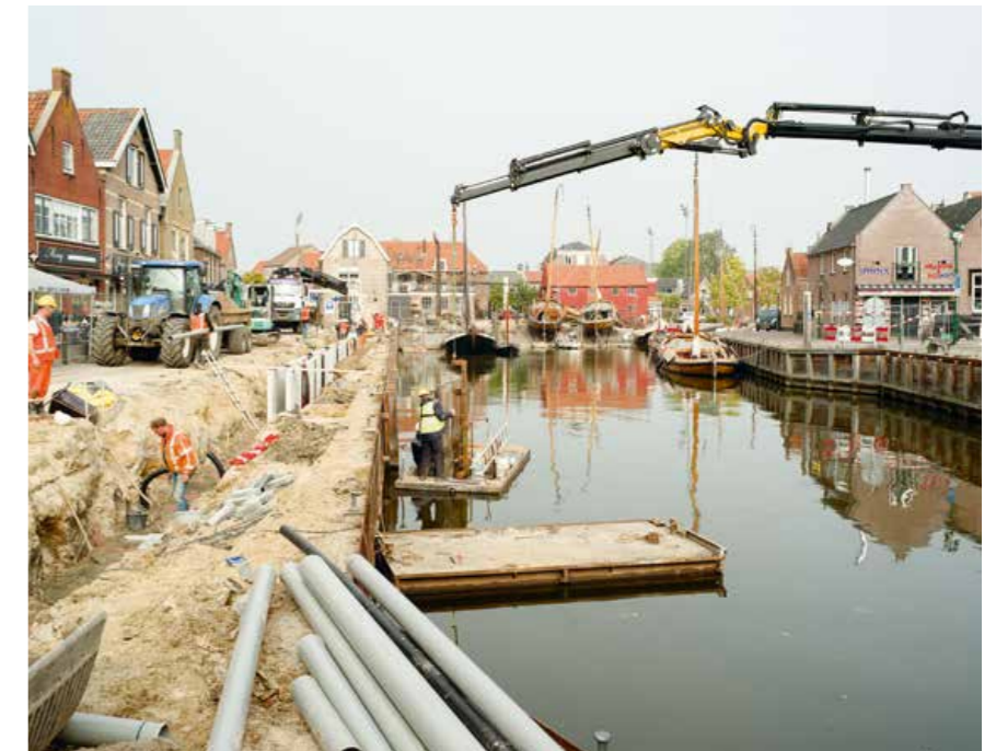
Aanleg van de zelfoprijvende kering in Spakenburg.
