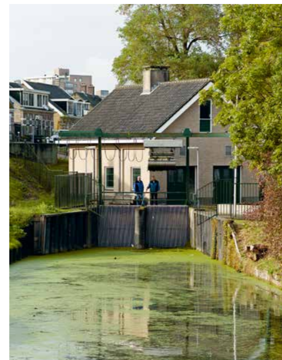
Onderhoudswerkzaamheden bij het gemal aan de Schielands Hoge Zeedijk in Capelle aan de IJssel.
