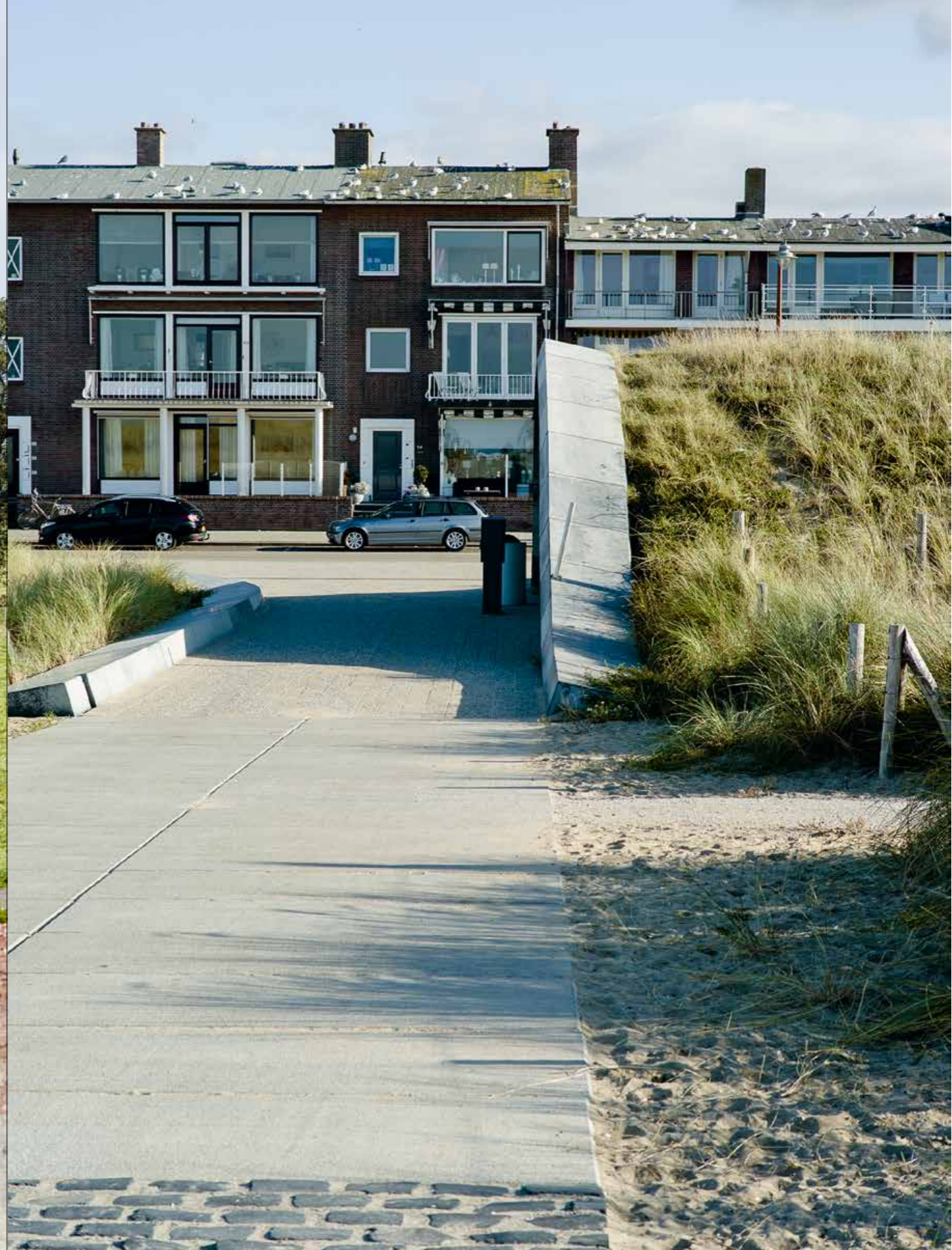
Bebouwing aan de boulevard bij Kustwerk Katwijk.
