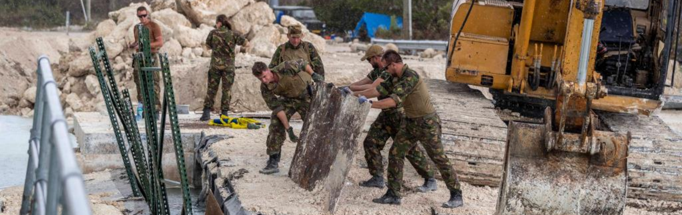
Genisten worden ook ingezet voor Internationale Noodhulp. Hier ruimen zij een ingestorte brug op eiland Great Abaco van de Bahama's op na orkaan Dorian. Daarna bouwden zij een tijdelijke brug (september 2019).
