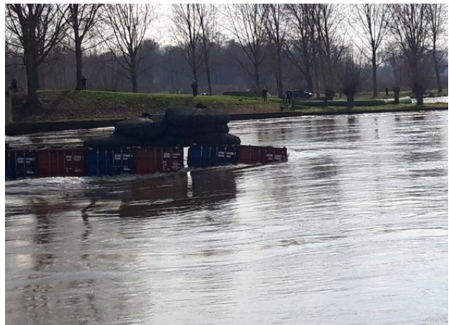
Figuur 7 Rock Bags op containers bij stuw Linne om containers te ballasten (Bron Wim Kortlever)
